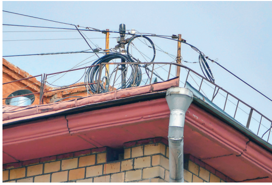
Интернет-провайдеры часто входят в дом через крышу / И. СТУЛОВ / ВЕДОМОСТИ
